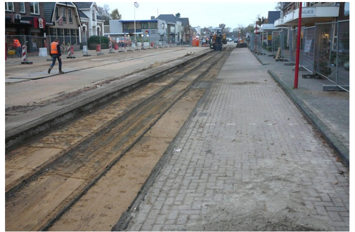
Frezen van het asfalt.
