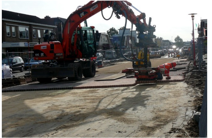
Het leggen van de stenen.
